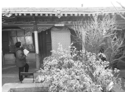
图 17 院内倒座房正面照
